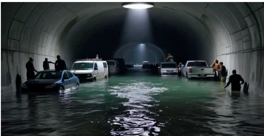
In die Tunnel einströmende Niederschläge führen zu unvorhersehbaren Risiken.
