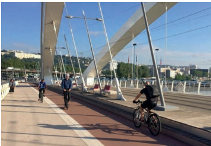
Die neue Brücke für den „weichen Verkehr“ über die Rhône.
