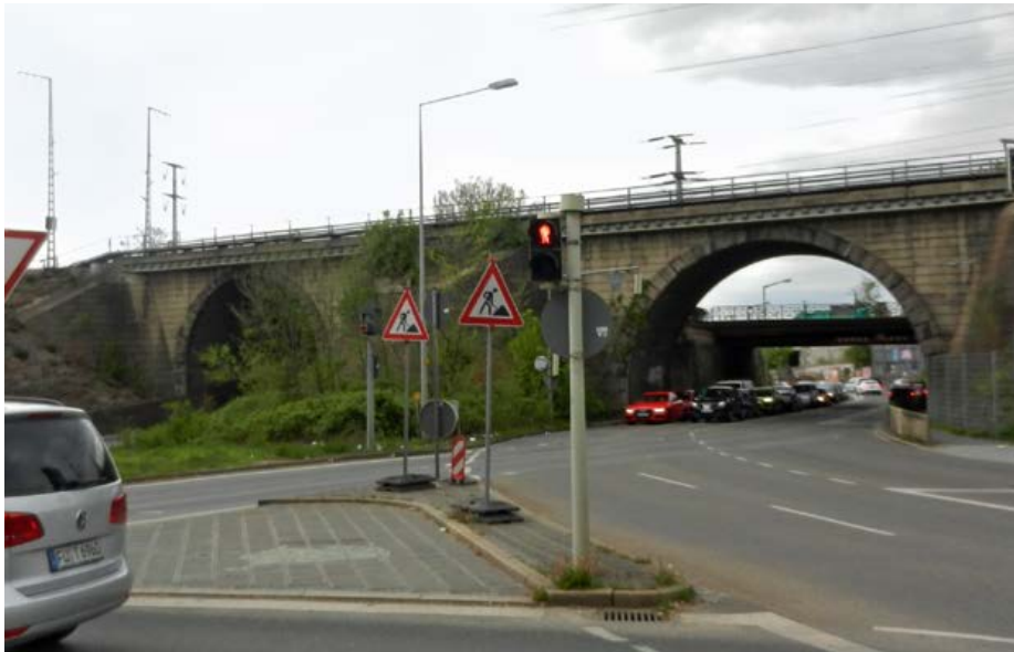
Wie kann man diesen Brückenpfeiler nur übersehen ... ?
