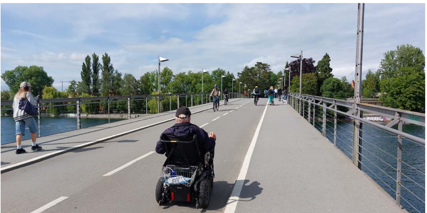
Und noch mal Konstanz – eine überaus attraktive Brücke über den Rhein, nur für den Fuß- und Radverkehr!
